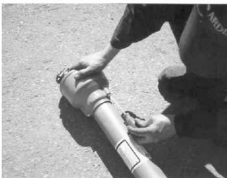
Демонтаж защитного кожуха
